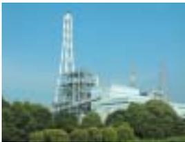
硫黄酸化物を除去する炉内脱硫方式により、排煙脱硫装置が不要となることなどから、発電所をコンパクトにすることができるといった特徴がある。
