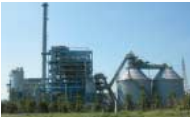
みやざきバイオマスリサイクル(株) 鶏ふん焼却発電施設
