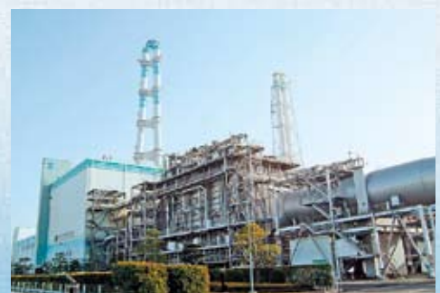
新大分発電所(LNG火力)
