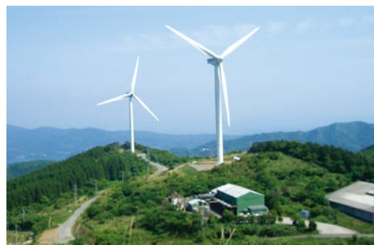
長島風力発電所
