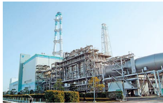
新大分発電所(LNG火力)
