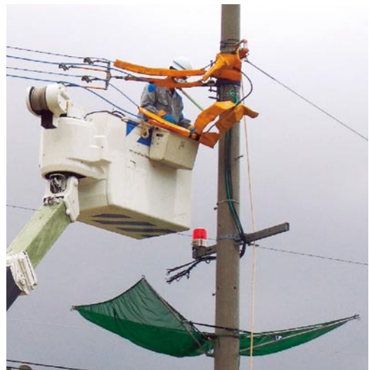
配電工事中の落下防止ネット使用の様子
