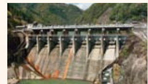
山須原ダム(改造前)
