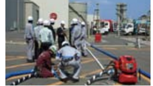
仮設ポンプ設置
