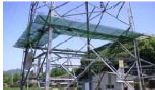
送電鉄塔の昇塔防止装置設置状況
