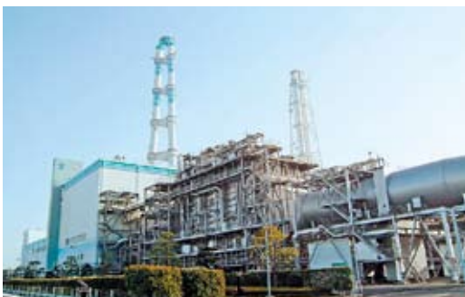
新大分発電所(LNG火力)
