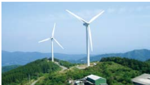
長島風力発電所
