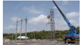
仮鉄柱組立・据付
