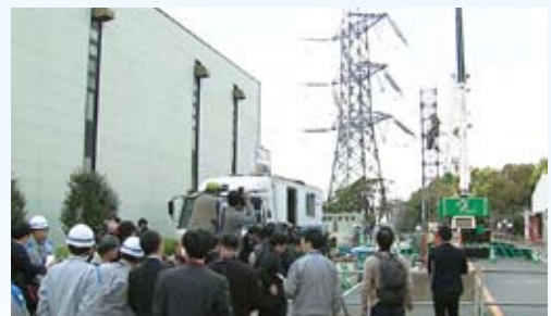
外部電源復旧訓練(自主訓練)の公開の様子
