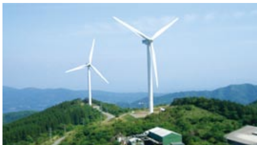
長島風力発電所
