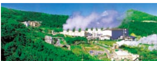
八丁原発電所
