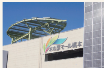
木の葉モール橋本 (リーフ型屋根と壁面設置)
