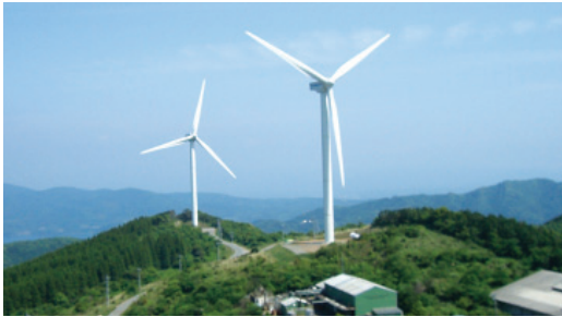
長島風力発電所
