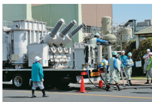
●移動用機器による電力供給訓練
