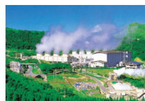
八丁原発電所
