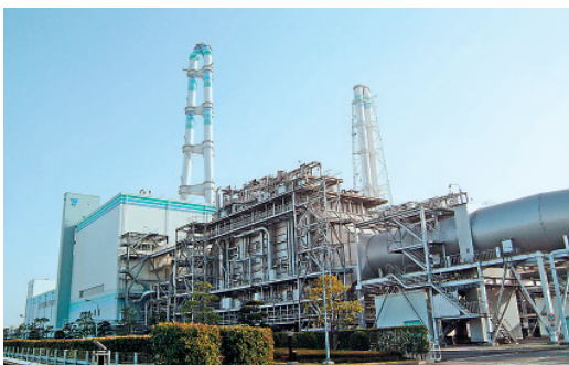
新大分発電所(LNG火力)
