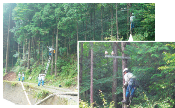
倒壊した電柱の代わりに杉の木に電線を架線している様子(熊本県球磨郡)
