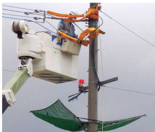
配電工事中の落下防止ネット使用の様子
