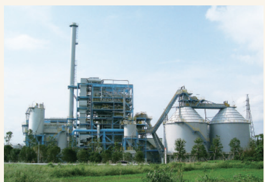
みやざきバイオマスリサイクル発電所
