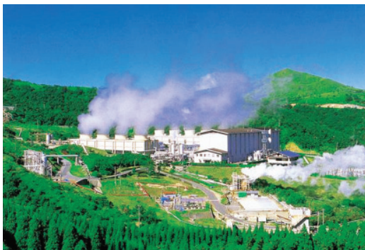
八丁原発電所
