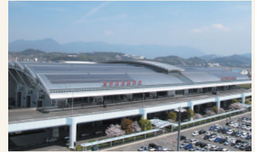
福岡空港国際線ターミナル (エネルギーサービス方式)
