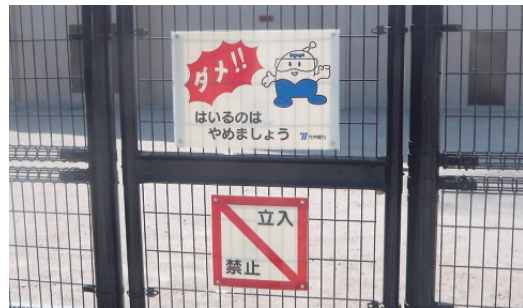
変電所の注意喚起標識設置状況
