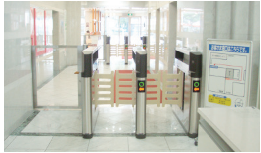
宮崎支社セキュリティゲート
