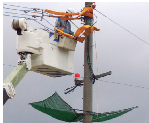
配電工事中の落下防止ネット使用の様子
