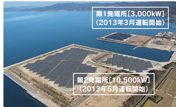
大村メガソーラー発電所(長崎県大村市)
