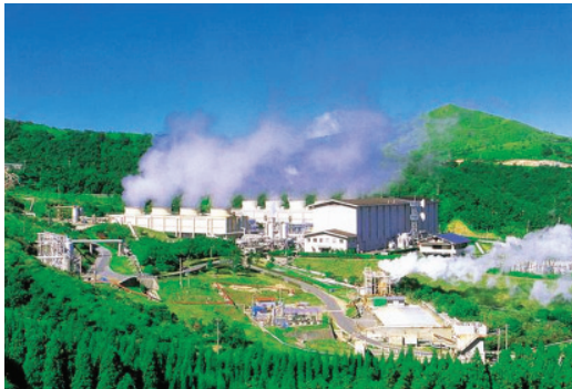
八丁原発電所
