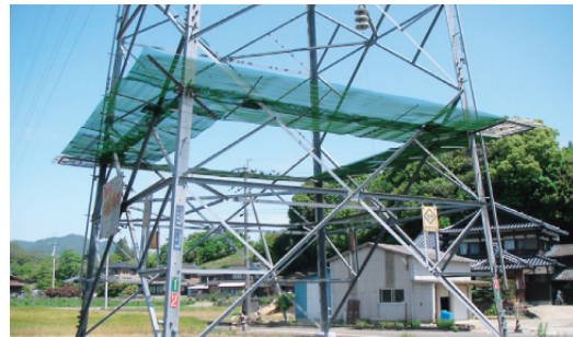
送電鉄塔の昇塔防止装置設置状況
