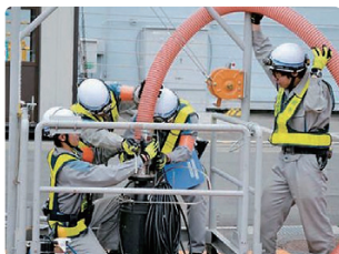
仮設ポンプ・ホースを使った 原子炉等を冷却するための 給水訓練
