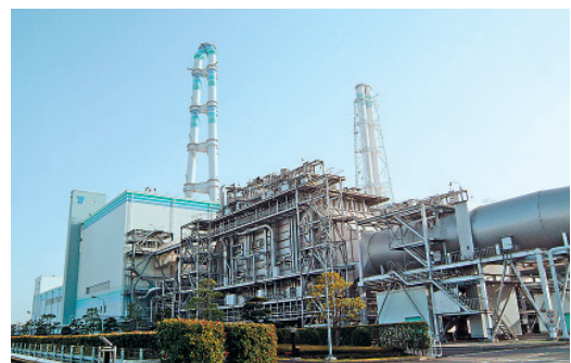
新大分発電所(LNG火力)
