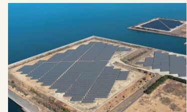
大村メガソーラー発電所 (メガソーラー発電事業)
