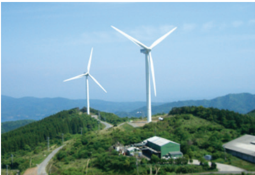
長島風力発電所
