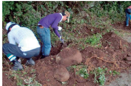
林道側溝の復旧作業(土砂・石除去作業)
