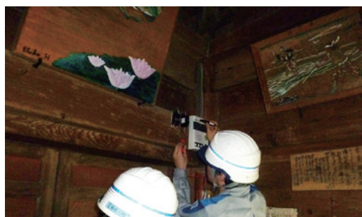
重要文化財配線診断(人吉営業所)
