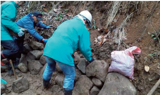
棚田の石積み復旧作業
