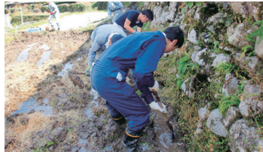
棚田の畦及び水路の復旧作業
