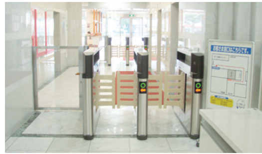
宮崎支社セキュリティゲート
