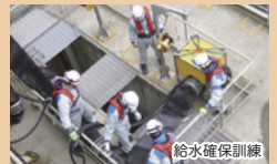
給水確保訓練
