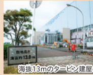
海抜13.0mのタービン建屋
