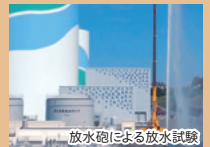
放水砲による放水試験
