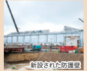
新設された防護壁
