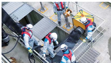
海水を取水する水中ポンプの設置
