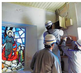
田平天主堂(長崎県平戸市)での配線点検
