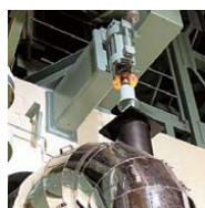
地震対策(支持構造物補強)
