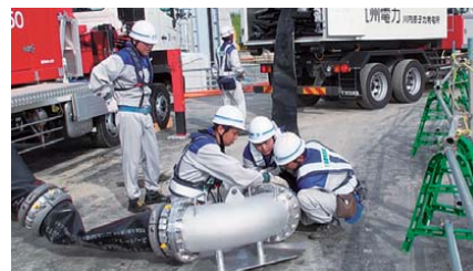
ホースの敷設
