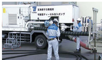
冷却水の供給訓練
