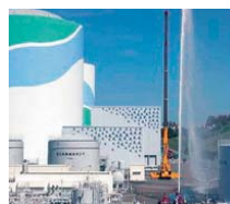
放水砲による放水訓練
