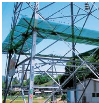
送電鉄塔の昇塔防止装置設置状況
