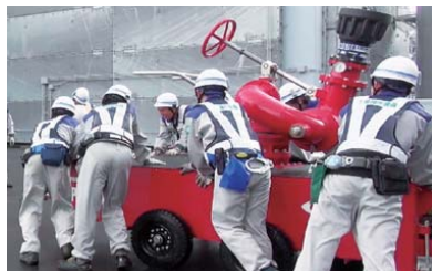
放水砲の設置
