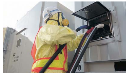
中容量発電機車の電源ケーブル接続
