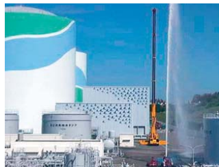
放水砲による放水
