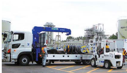
電源ケーブルの運搬
