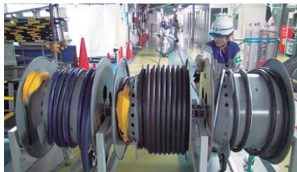
電源ケーブルの敷設(屋内)
