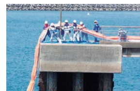
シルトフェンス(海中カーテン)設置訓練
