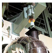
地震対策(支持構造物補強)
