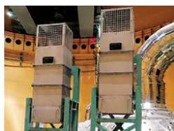
静的触媒式水素再結合装置
