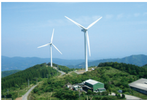
長島風力発電所
