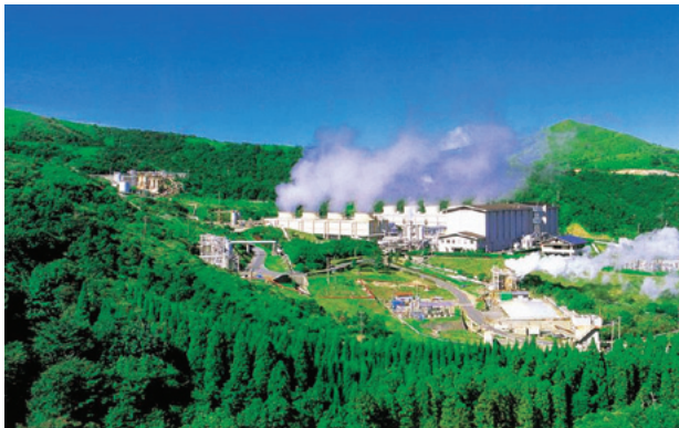
八丁原発電所
