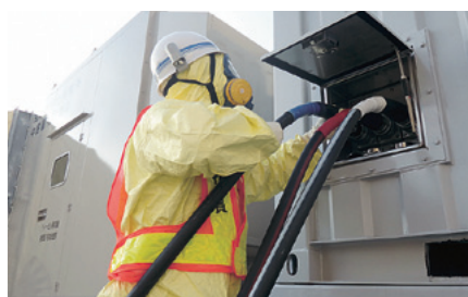
中容量発電機車の電源ケーブル接続
