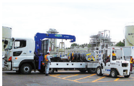
電源ケーブルの運搬
