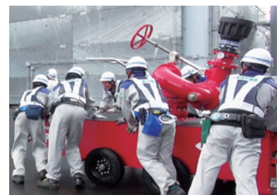
放水砲の設置
