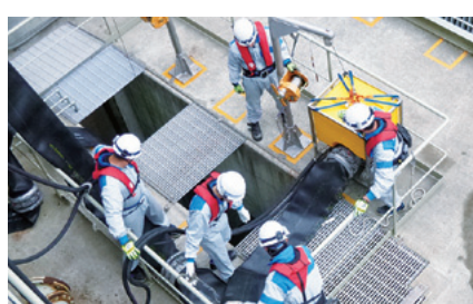
海水を取水する水中ポンプの設置
