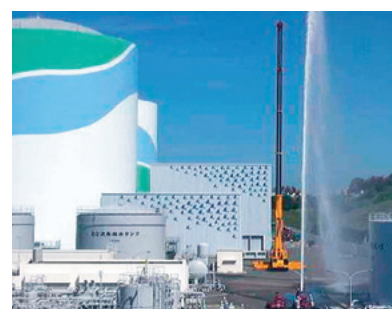
放水砲による放水
