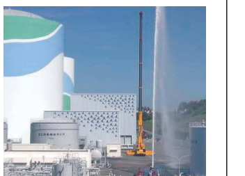
◇放水砲による放水
