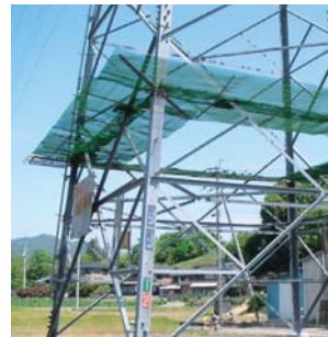
送電鉄塔の昇塔防止装置の設置
