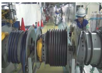
◇電源ケーブルの敷設(屋内)
