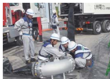
◇ホースの敷設
