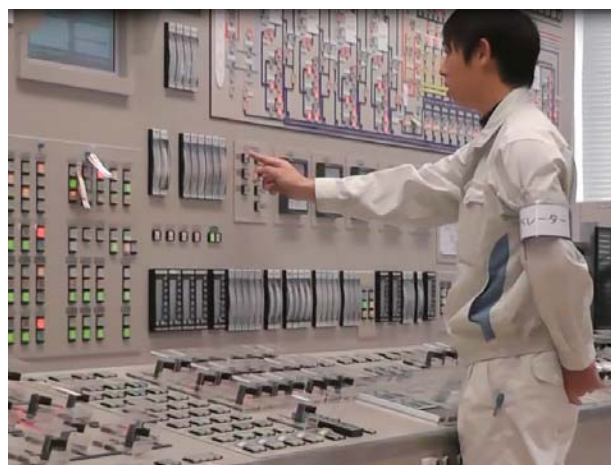
中央制御室の遠隔操作で棧橋とLNG船をつなぐロープを切り離す様子
