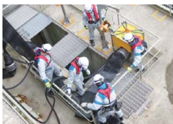
◇海水を取水する水中ポンプの設置
