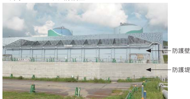
▼海水ポンプエリア防護壁
