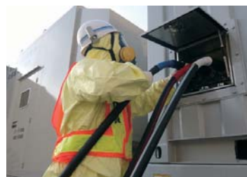
◇中容量発電機車の電源ケーブル接続
