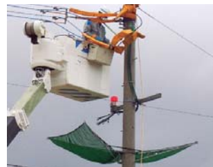
配電工事中の落下防止ネット使用
