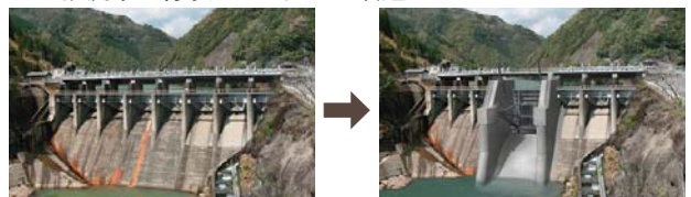
山須原ダム(改造前)
