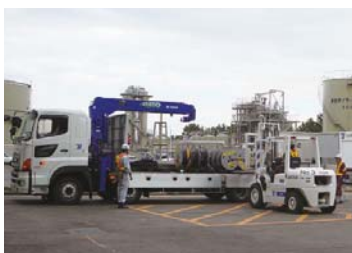
◇電源ケーブルの運搬
