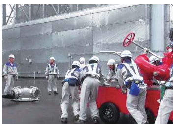
◇放水砲の設置
