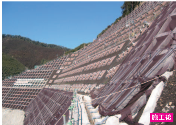
下部ダム周辺法面緑化状況
