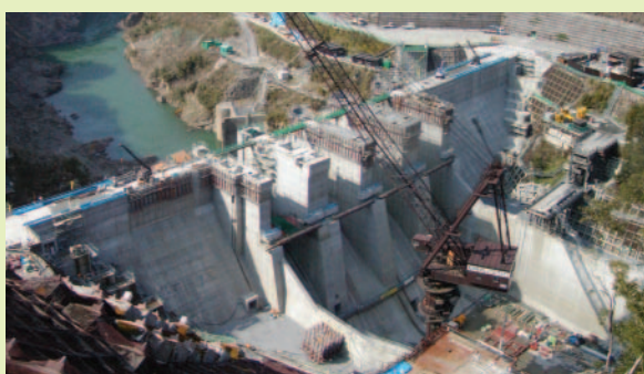
掘削とダム本体のコンクリート打設が完了し、洪水吐ゲートの据え付け等を行っています。
