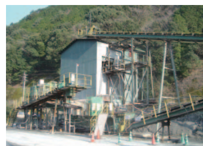
製砂設備の防音建屋
