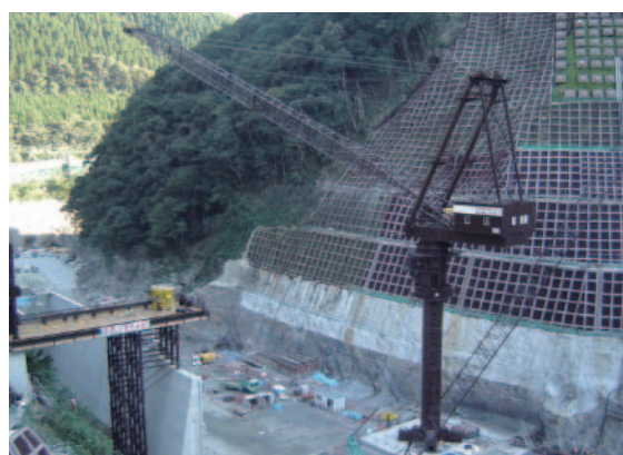
タワークレーンの低明度塗装
