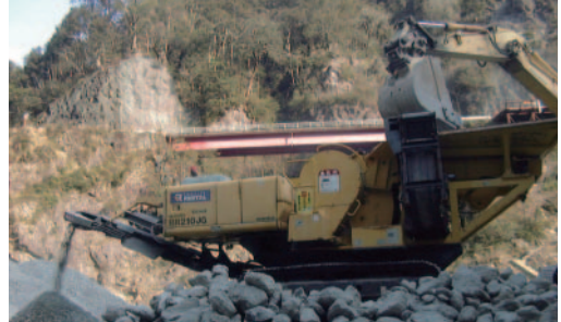
コンクリートがらのリサイクル
