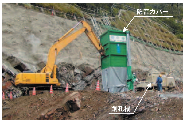
防音カバー設置
