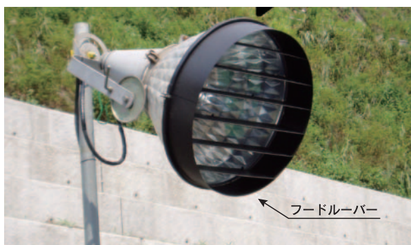
フードルーバーの取り付け
