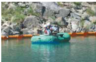
オイルフェンス設置及び油回収
