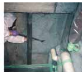
吹付け石綿の除去
