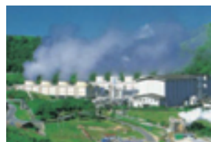
八丁原発電所
