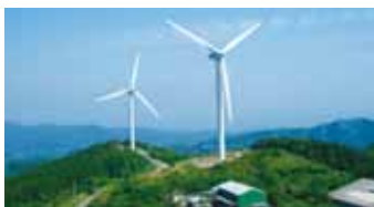
長島風力発電所(鹿児島県出水郡長島町)
