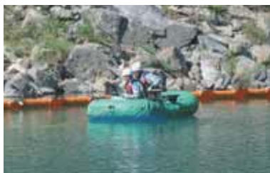
オイルフェンス設置及び油回収
