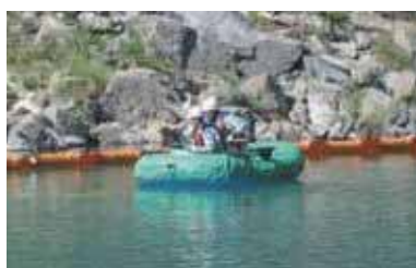
オイルフェンス設置及び油回収
