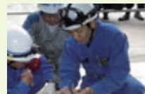
ファン軸受の点検検査状況
