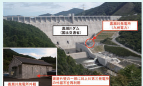
嘉瀬川ダム・発電所の状況
