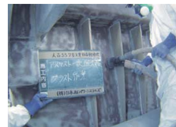
石綿除去作業状況
