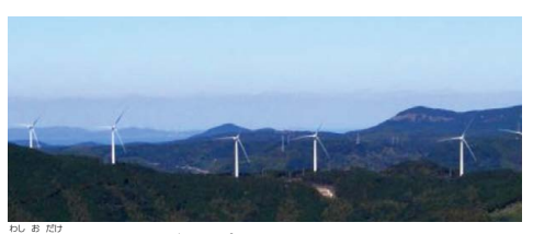
鷲尾岳風力発電所(グループ会社の鷲尾岳風力発電(株))
