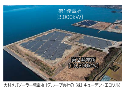
大村メガソーラー発電所(グループ会社の(株)キューデン・エコソル)
