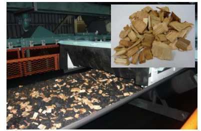
苓北発電所石炭と混ぜられた木質チップ（粉碎前）
