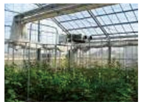
ヒートポンプ利用栽培 (パラ栽培農家)
