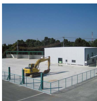
再生骨材製造プラント
