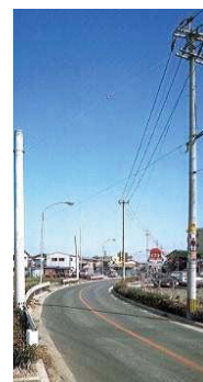
コンクリートポール
