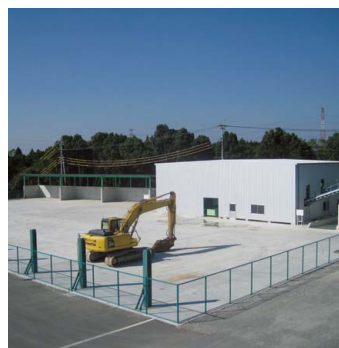
再生骨材製造プラント
