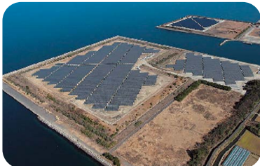
大村メガソーラー発電所(グループ会社の(株)キューデン・エコソル)
