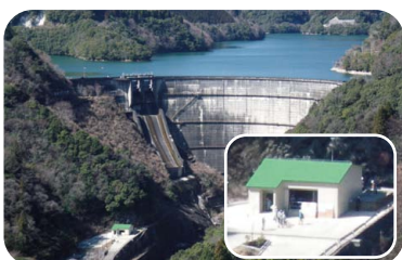
上椎葉ダムと上椎葉維持流量発電所
