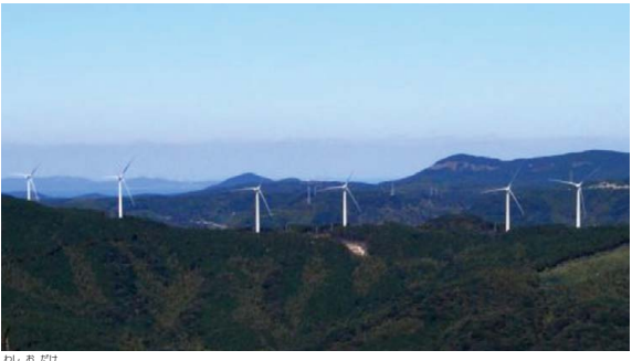
鷲尾岳風力発電所（グループ会社の鷲尾岳風力発電（株））
