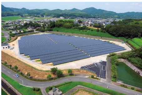
アスティソーラー発電所（福岡県宗像市）
