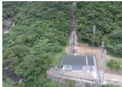
新名音川発電所
