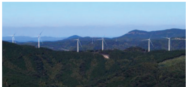
鷲尾岳風力発電所(グループ会社の鷲尾岳風力発電(株))
