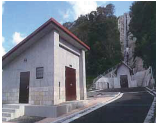
西技工業(株) 龍門滝発電所(奥は落差約50mの水圧鉄管)
