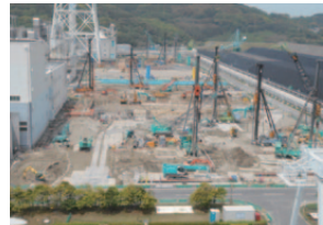
建設工事の様子
