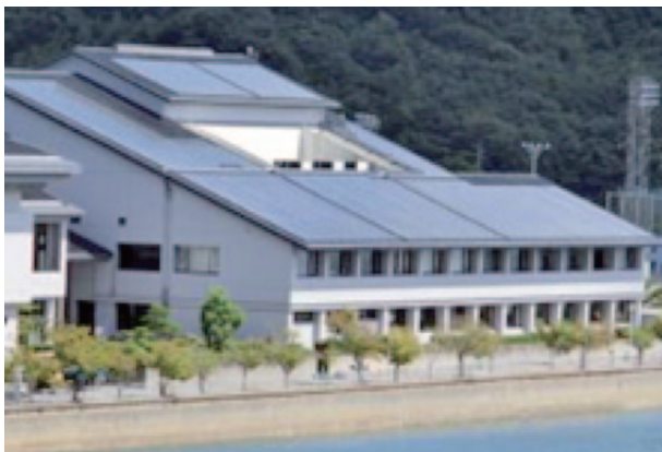
佐賀県玄海町の実証試験設備 <太陽光発電設備(屋根設置)>
