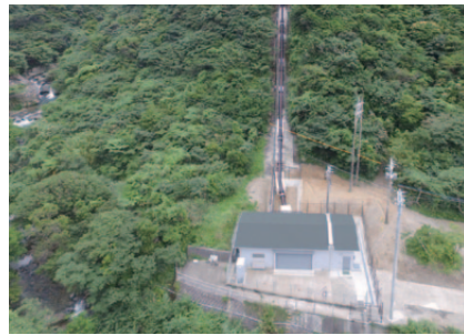
新名音川発電所
