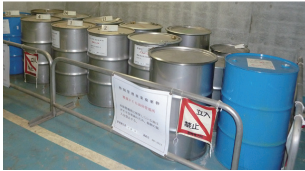
PCB廃棄物の保管・管理状況
