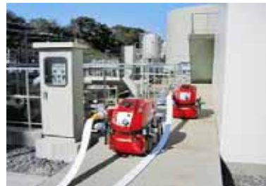
仮設ポンプ、仮設ホース
