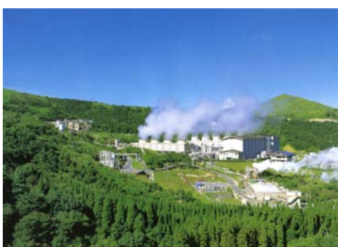
八丁原発電所（大分）
