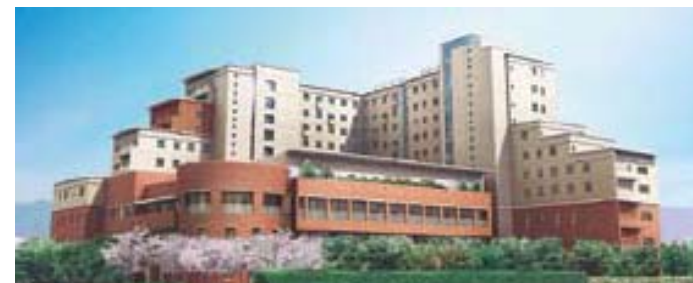
グランガーデン福岡浄水 完成イメージ (H22. 5 営業開始予定)
