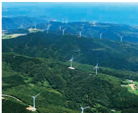
長島風力発電所
