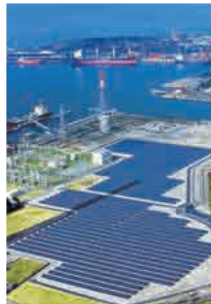
メガソーラー大牟田発電所
