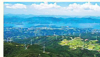
長島風力発電所
