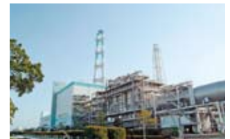
新大分発電所
