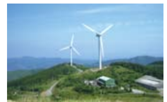
長島風力発電所 （長島ウィンドヒル株式会社）
