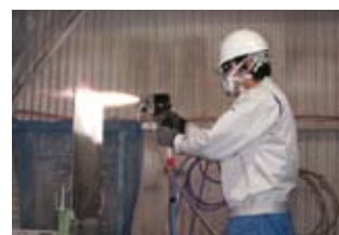
プラズマワイヤー工法
