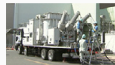
移動用機器による電力供給訓練
