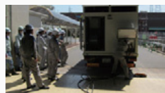
高圧発電機車による電源供給訓練
