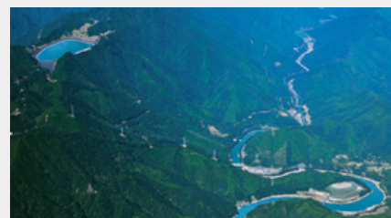
小丸川発電所(宮崎)
