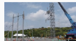
鉄塔等の仮復旧訓練
