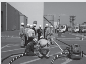
仮設ポンプ設置
