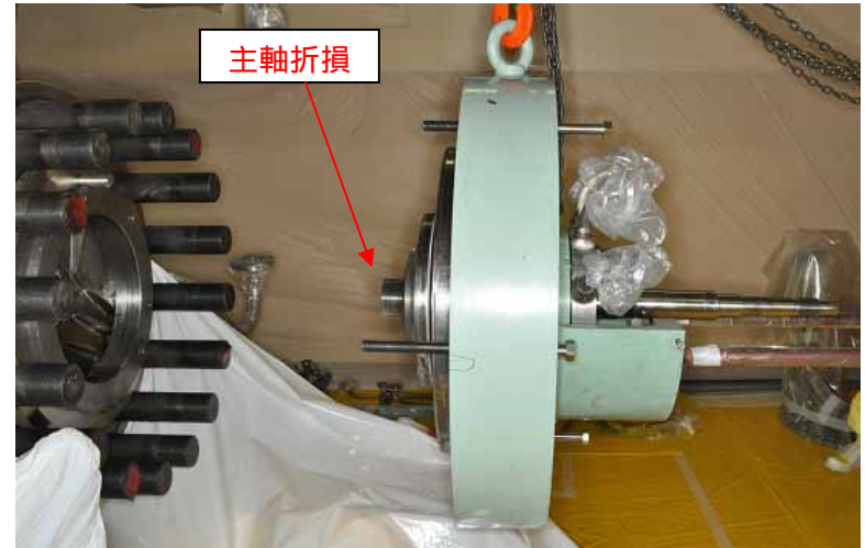
主軸の折損状況
