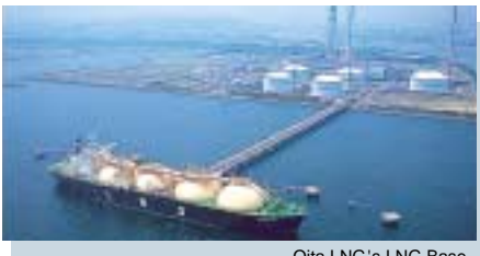
Oita LNG's LNG Base
