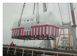
船から発電機を陸揚げする様子
