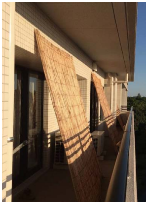
「よしず」による遮光対策(上) 自作のオーニング(日よけシート)による遮光対策(右)
