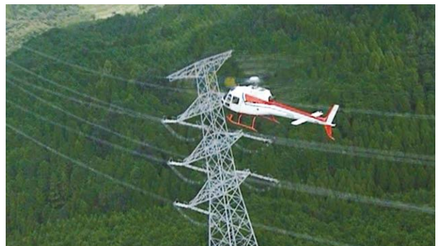
当社管内におけるヘリコプターによる設備巡視の様子
